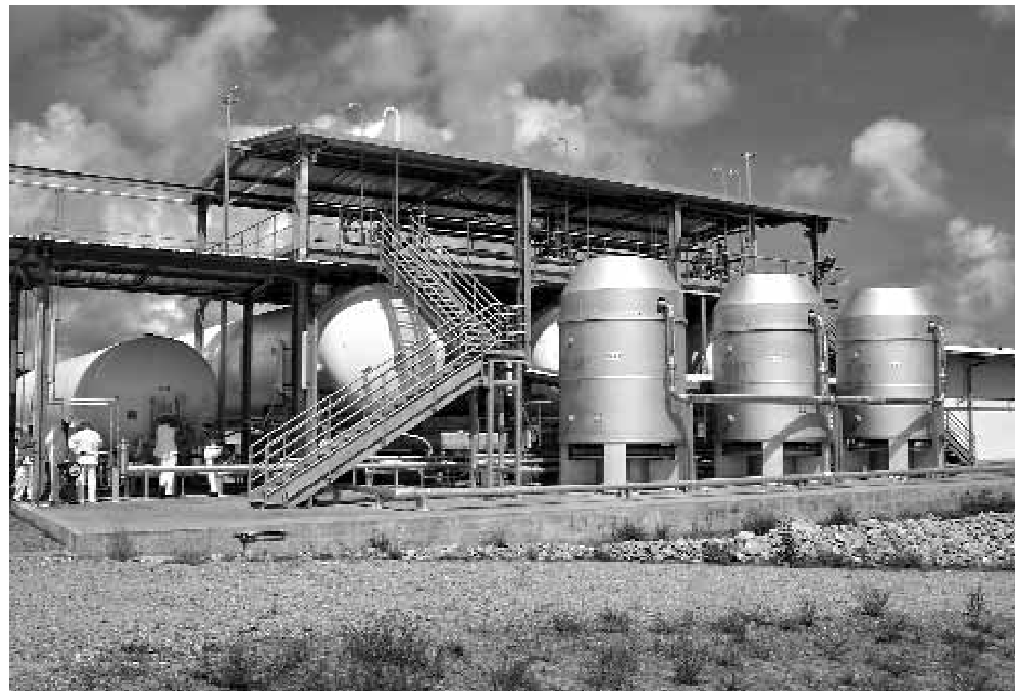
Система хранения и заправки жидким кислородом и азотом на космодроме Куру
